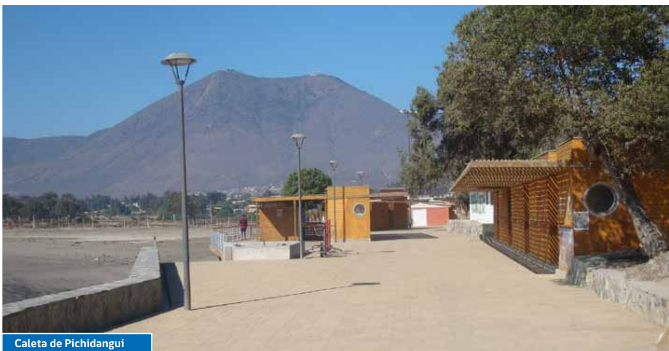
Captación y paneles solares Sistema de APR Medialuna-Combarbalá
