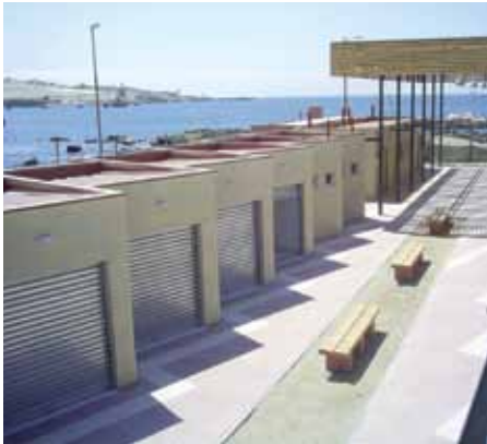
Mejoramiento Puerto pesquero de Caldera (Boxes), Comuna de Caldera
