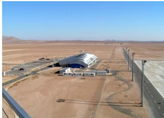
Principales Obras: Edificio terminal de pasajeros de 3.000 m<sup>2</sup>; Pista de aterrizaje de 2.200 metros de largo; Rodajes y plataforma de estacionamiento para 4 aviones tipo Airbus-320; Equipamiento Aeroportuario; Torre de Control, edificio DGAC y Cuartel SEI; Planta de tratamiento de aguas servidas; Vialidad de acceso al aeropuerto; Estacionamientos para automóviles; Zonas de circulación peatonal, tratamiento paisajístico, cierros de seguridad y otras obras.
