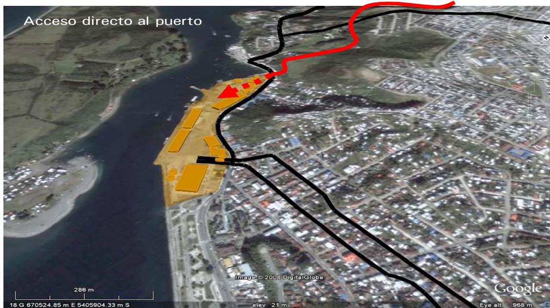
Figura 4-17 Accesos y elementos relevantes.
