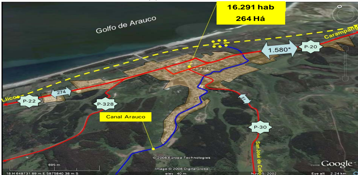
Figura 4-14 By-pass de Arauco.
